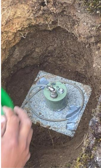
Fig 32: Instalación de sensor Terrazas
